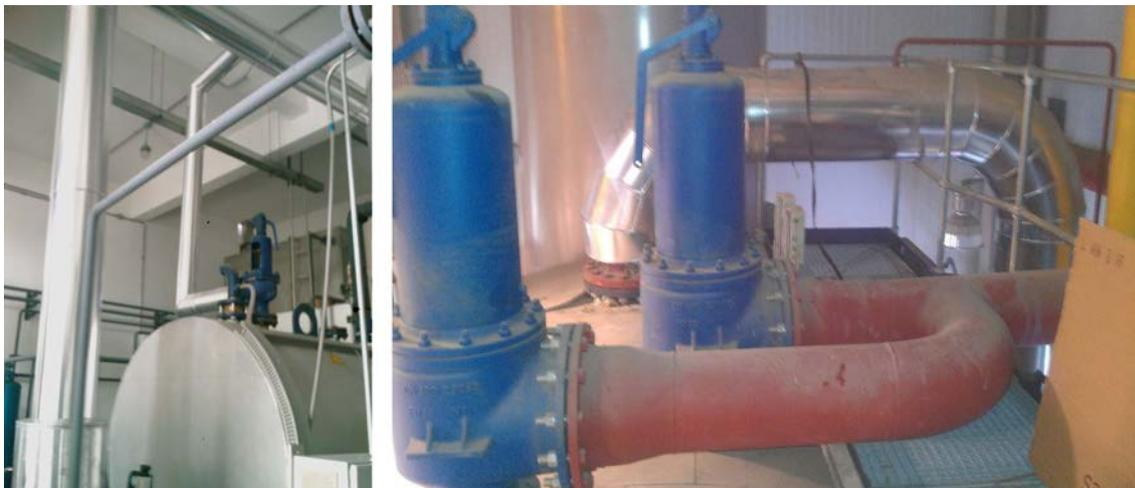
**Fig. 16** Combinaison inadmissible d'une soupape de sécurité et d'un tuyau de vapeur d'expansion
