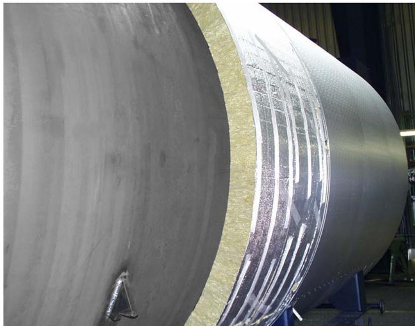
**Fig. 164** Éviter les ponts thermiques en isolant les coques cylindriques des chaudières et des conteneurs sans intercalaires
