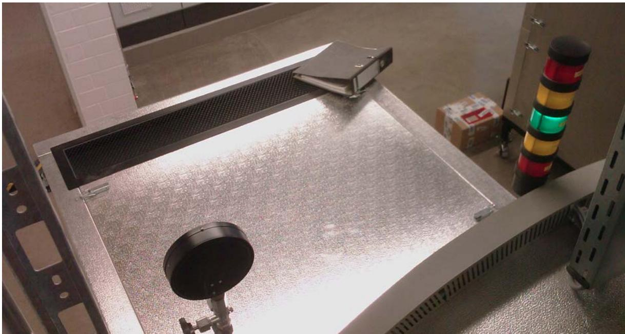
**Fig. 30** Risque de manque d'air en raison de bouchage des ouvertures de soufflage
