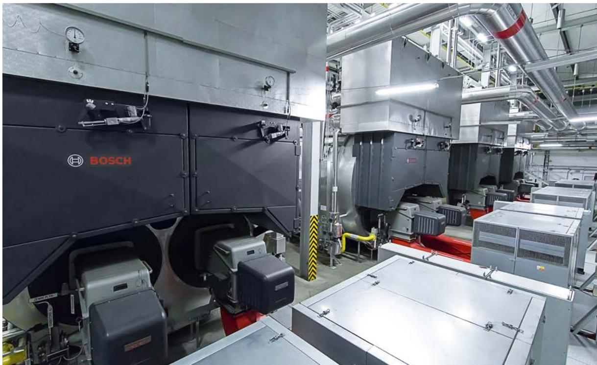
**Fig. 73** Chaudière à double foyer avec un surchauffeur monté au-dessus
