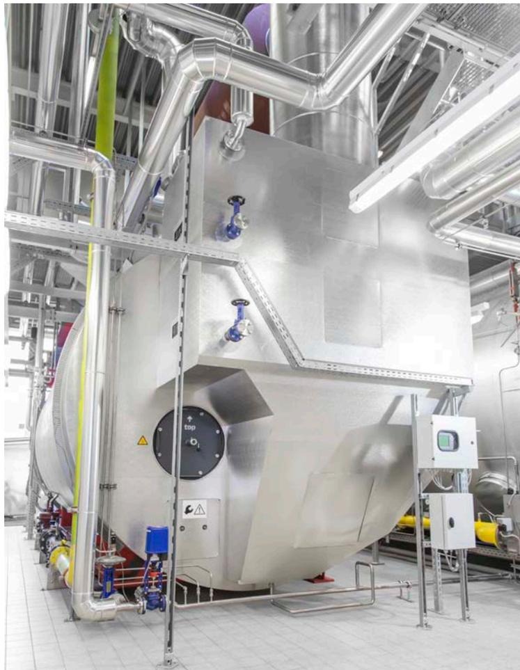
**Fig. 165** Isolation amovible au niveau des ouvertures d'inspection (UL-S avec économiseur intégré)
