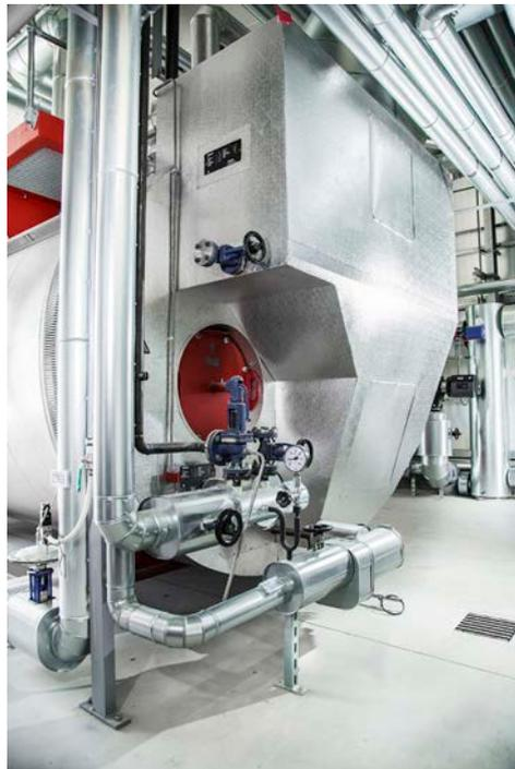
**Fig. 62** Bobine de maintien de la chaleur installée à la base de la chaudière
