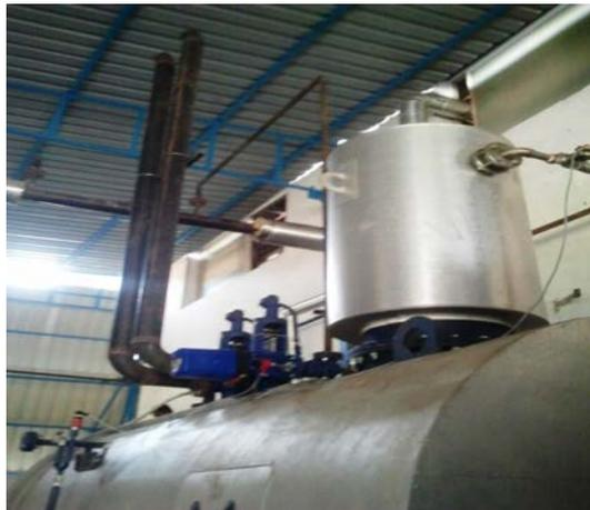
**Fig. 20** Supports des tubes de purge de la soupape de sécurité manquants
