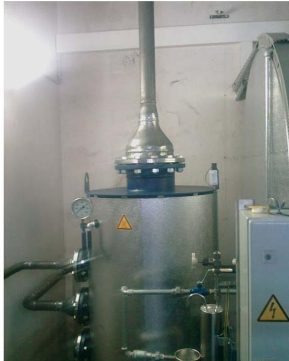
**Fig. 17** Si le diamètre interne des tuyaux de vapeur d'expansion est réduit, cela peut conduire à une augmentation de la pression et à la rupture du réservoir.
