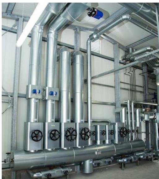
**Fig. 199** Distributeur de vapeur SD dans un système existant
