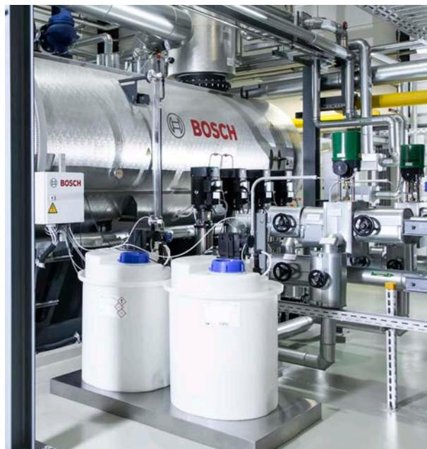
Fig. 178 Module de traitement de l'eau WSM
