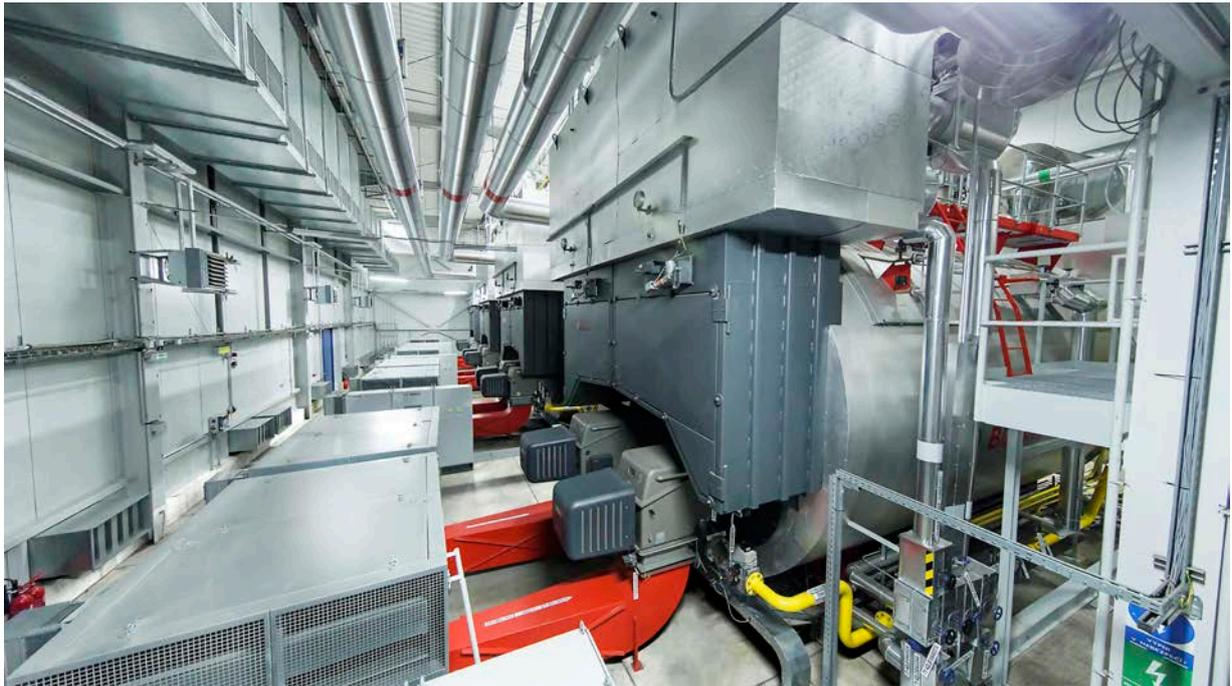
**Fig. 190** *Chaudière à Double tube de fumée avec module de surchauffage*
