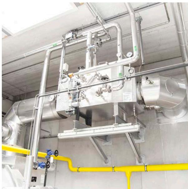
**Fig. 186** Echangeur de chaleur des gaz de combustion ECO 6 pour une utilisation en condensation
