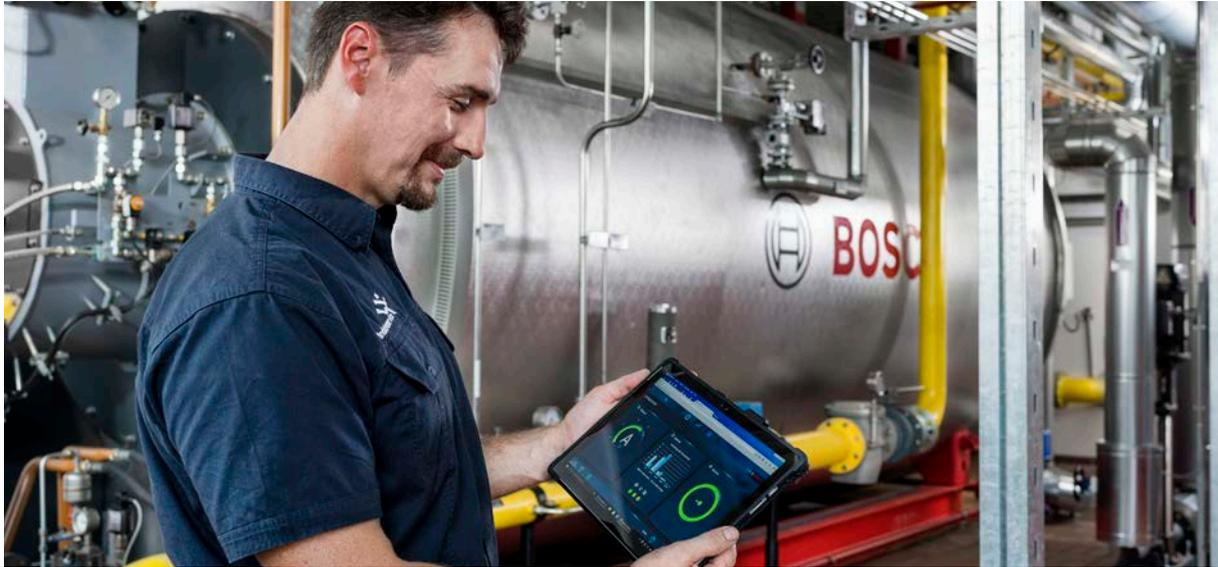
**Fig. 223** Efficacité et disponibilité en un coup d'oeil : MEC Optimize enregistre, évalue et visualise les données pour tous les composants connectés du système
