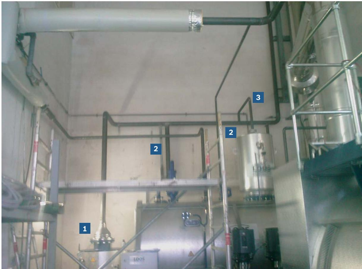
**Fig. 18** *Dérivation (1) du tuyau de vapeur d'expansion sur le réservoir de purge inférieur. Fusion (2) du conduit de vapeur d'expansion, du conduit de purge de la soupape de sécurité et du conduit de vapeur d'échappement. Le conduit de vapeur d'échappement n'est pas en acier inoxydable(3).*
