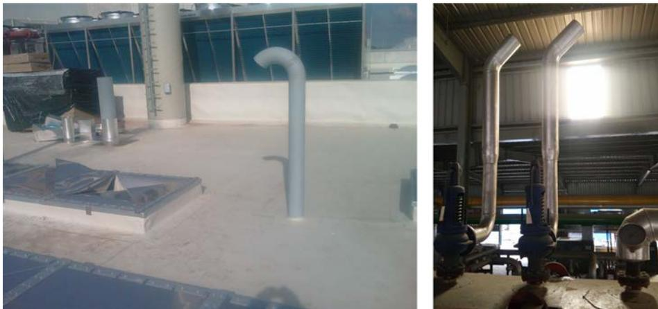
**Fig. 19** *Tuyau de purge de la soupape de sécurité*
