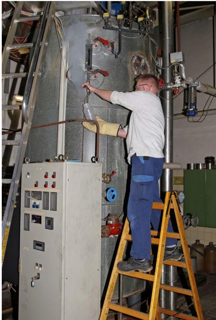
**Fig. 34** Prélèvement d'eau sans refroidisseur approprié et avec un récipient inadéquat
