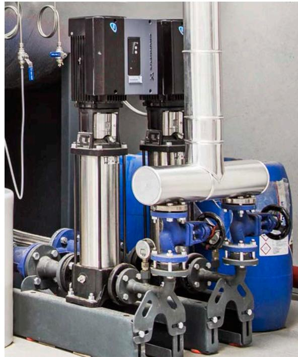
**Fig. 78** Module de pompe et double module
