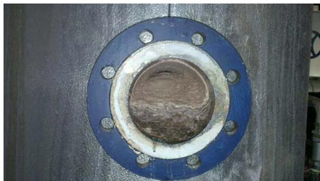
**Fig. 32** Débordement au BEM enlevé ; calcification complète au BEM
