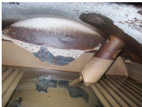
**Fig. 23** Dépôts côté eau sur le panneau et la plaque tubulaire de la chaudière
