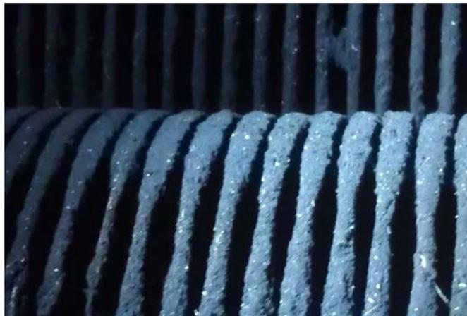
**Fig. 29** Dépôts sur les côtes de l'économiseur
