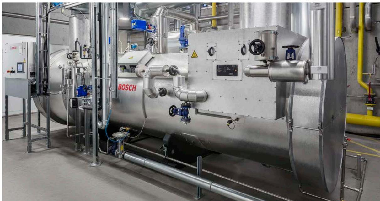
Fig. 191 Chaudière à vapeur de récupération de chaleur UNIVERSAL avec système HRSB
