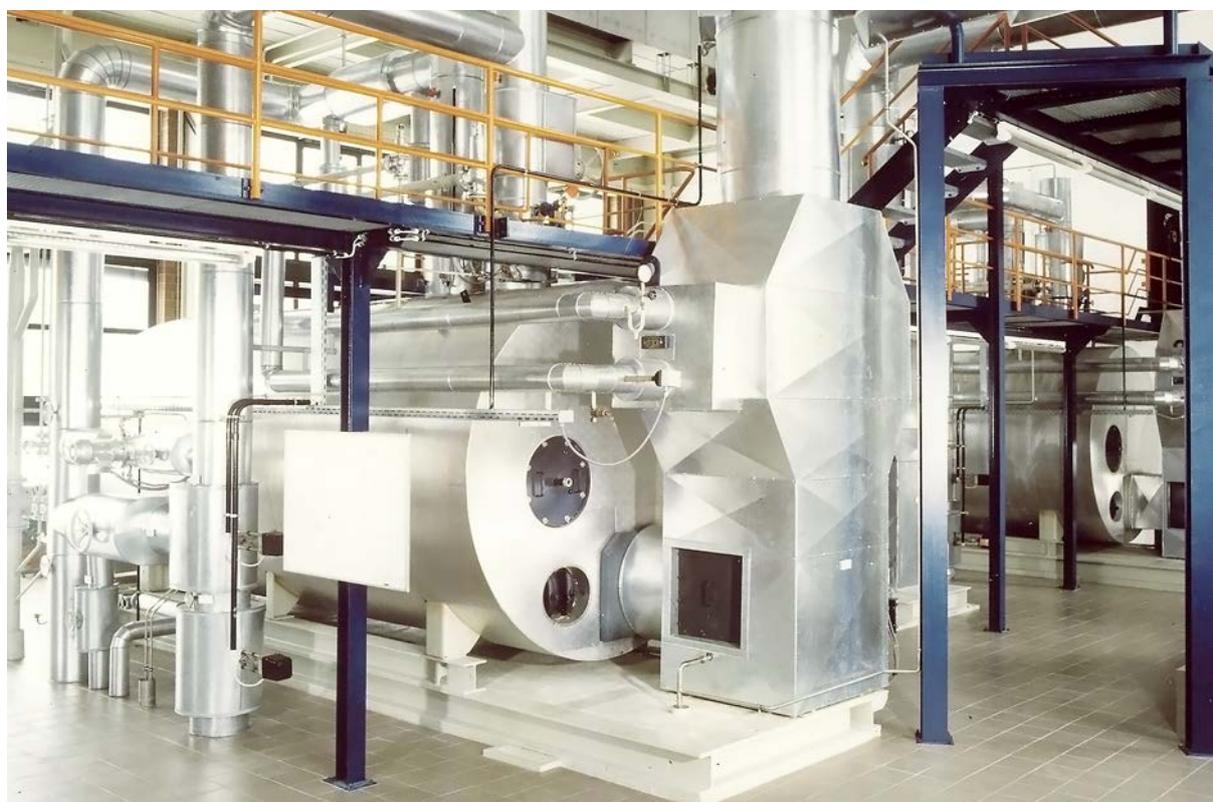
**Fig. 67** Économiseur Standalone en combinaison avec un système à double combustion (gaz/fioul lourd)
