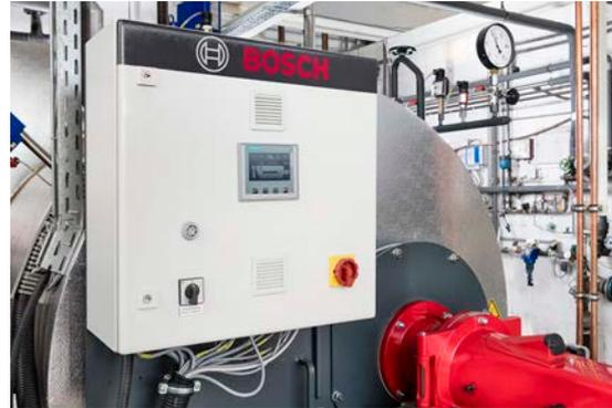
**Fig. 174** Compact steam control CSC pour chaudière à vapeur CSB
