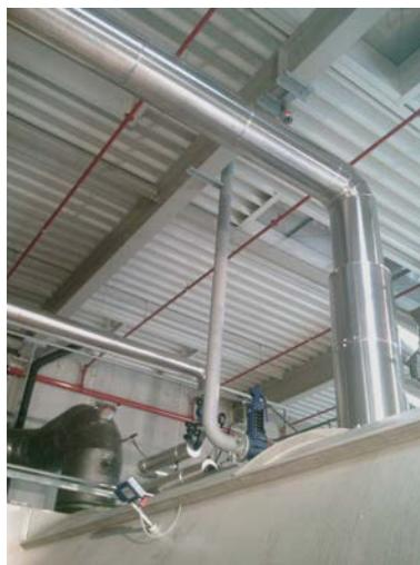
**Fig. 21** La dilatation thermique des tubes de purge de la soupape de sécurité n'est pas possible
