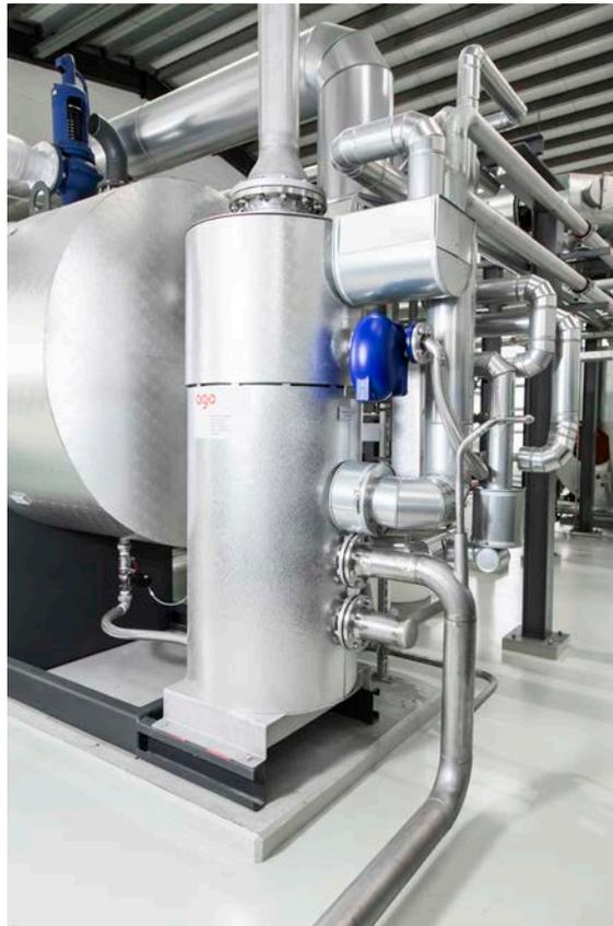
**Fig. 157** *Module d'expansion et de récupération de chaleur EHB*
