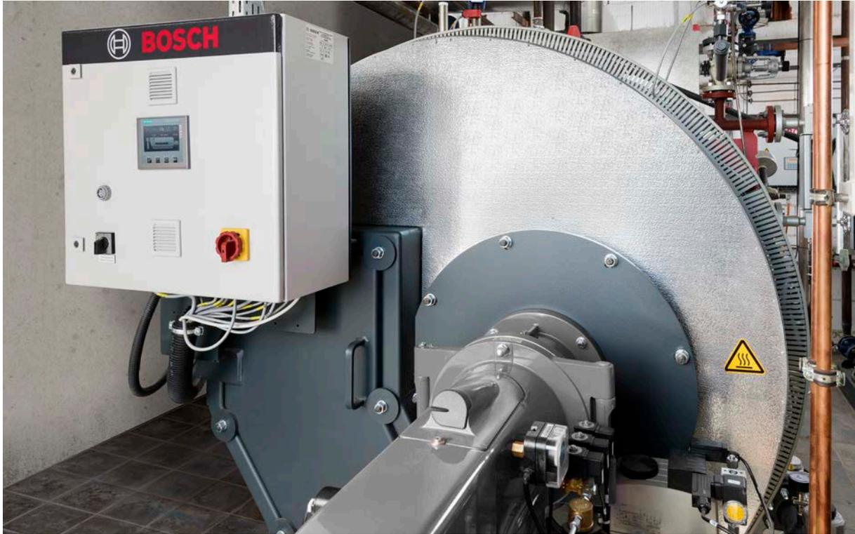
**Fig. 85** Armoire de commande compacte de CSC pour les chaudières à vapeur dans la plus petite gamme de puissance
