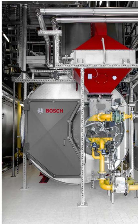
Fig. 146 Préchauffeur d'air
