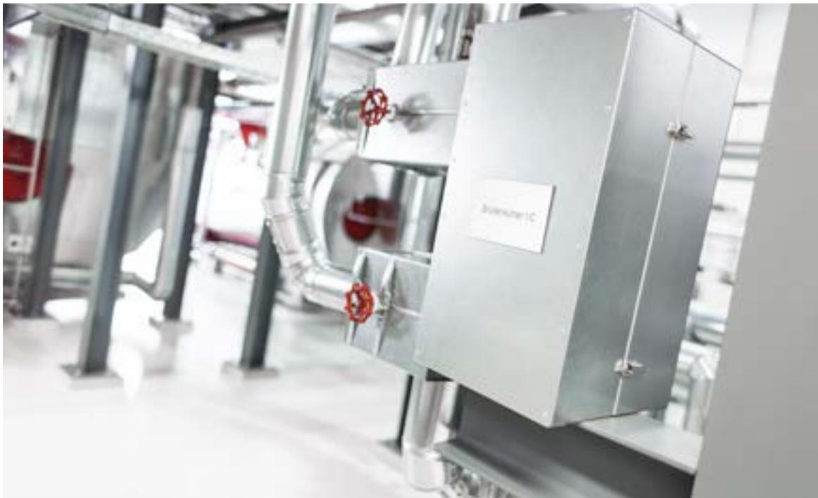
**Fig. 159** Vapour cooler
