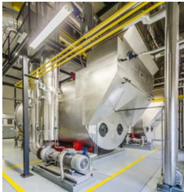
Integrované ekonomizéry v zadní části kotle
