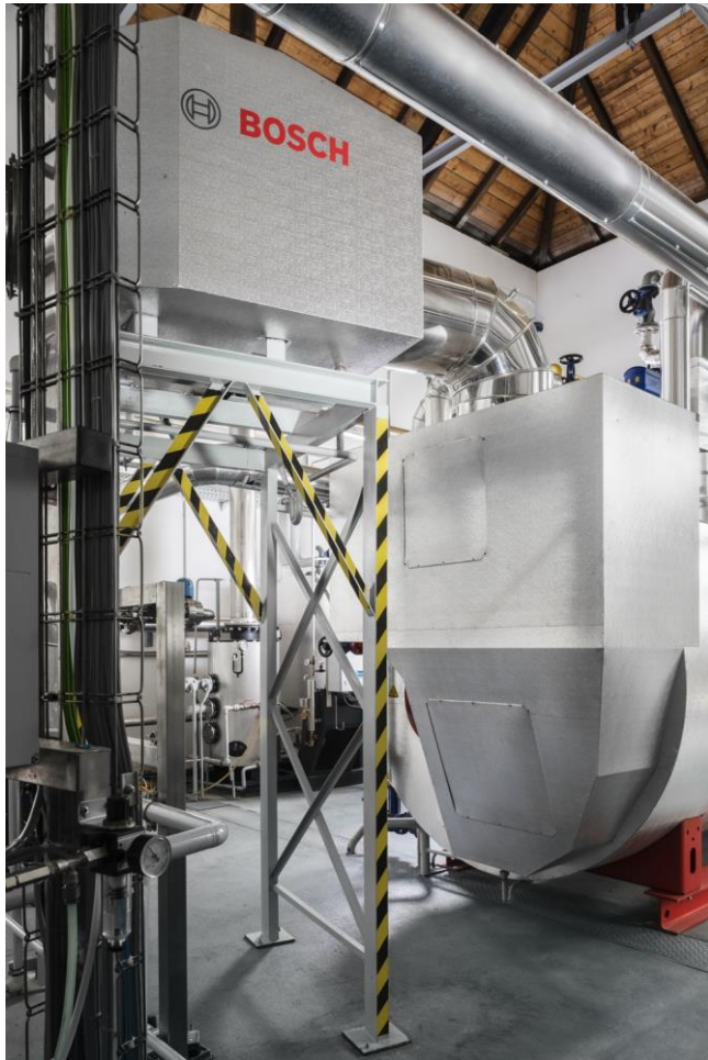
Economiser und Brennwertwärmetauscher: Kosten sparen und Ressourcen schonen mit effektiver Abwärmenutzung von Bosch.
