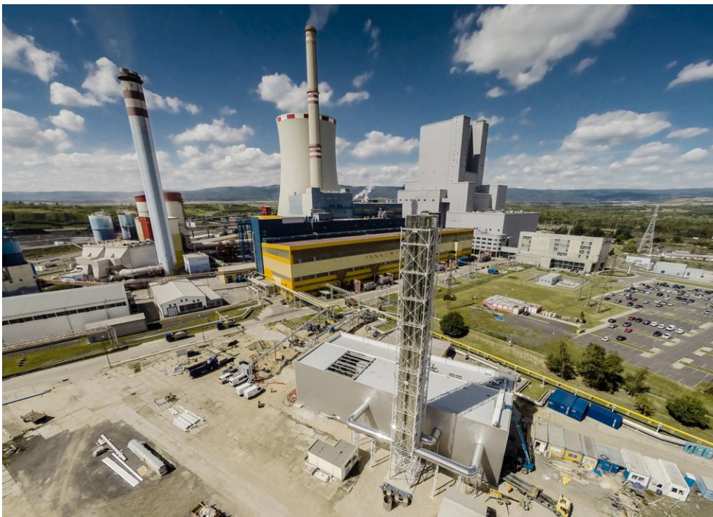
Das Kraftwerk Ledvice in Tschechien während Neubauphase des Kesselhauses.
