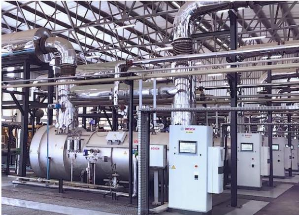
Die Abhitzedampfkessel von Bosch erzeugen 20 Prozent des Dampfbedarfs durch Abwärmenutzung bei International Breweries Plc.
