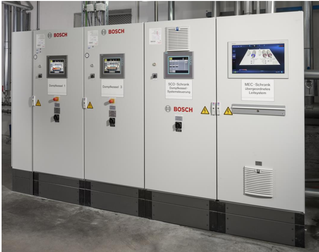
Die neuen Steuerungseinrichtungen für Kessel und Anlage mit übergeordneter Leittechnik Master Energy Control von Bosch.
