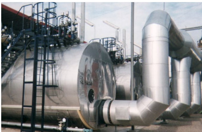
Abbildung 11: Wetterbeständige Isolierung für freistehende Kessel
