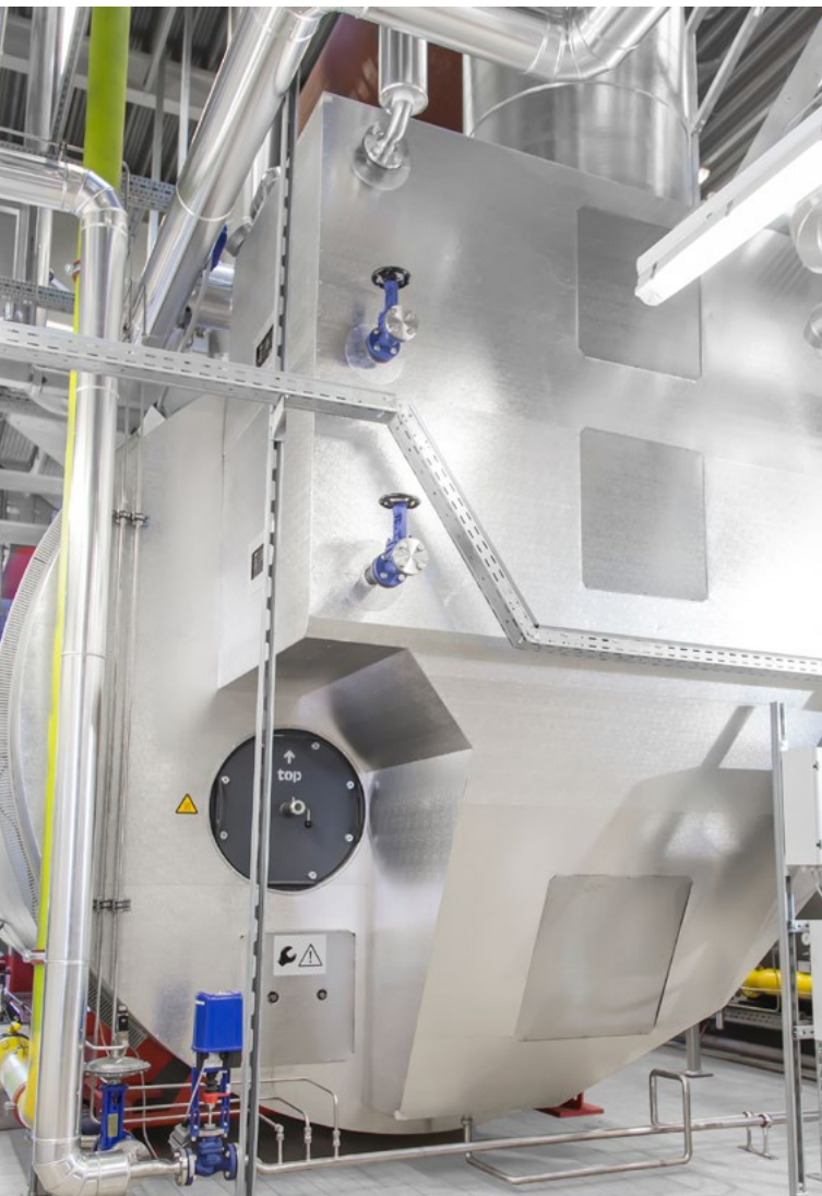
Abbildung 1: Ein UL-S, verkleidet mit strukturiertem Aluminiumblech und isolierten Revisionsöffnungen
