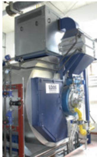
Ansicht des RAY Industrie-Gasbrenners mit LUVO zur Nutzung der überschüssigen Kompressorenabwärme
