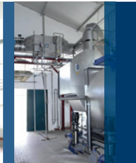
Anlage mit Economiser zur Speisewasservorwärmung und nachgeschaltetem Brennwert-Economiser zur Brauwassererwärmung
