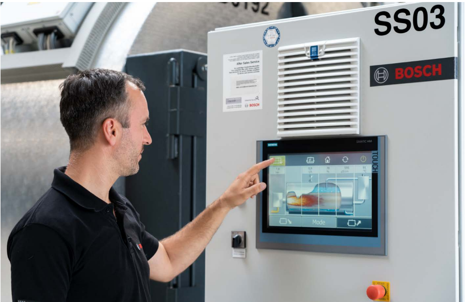
Kesselsteuerung
