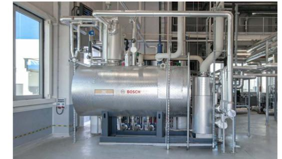
Bosch-Komponenten, wie die thermische Speisewasseraufbereitungsanlage, ergänzen das Kesselsystem.
