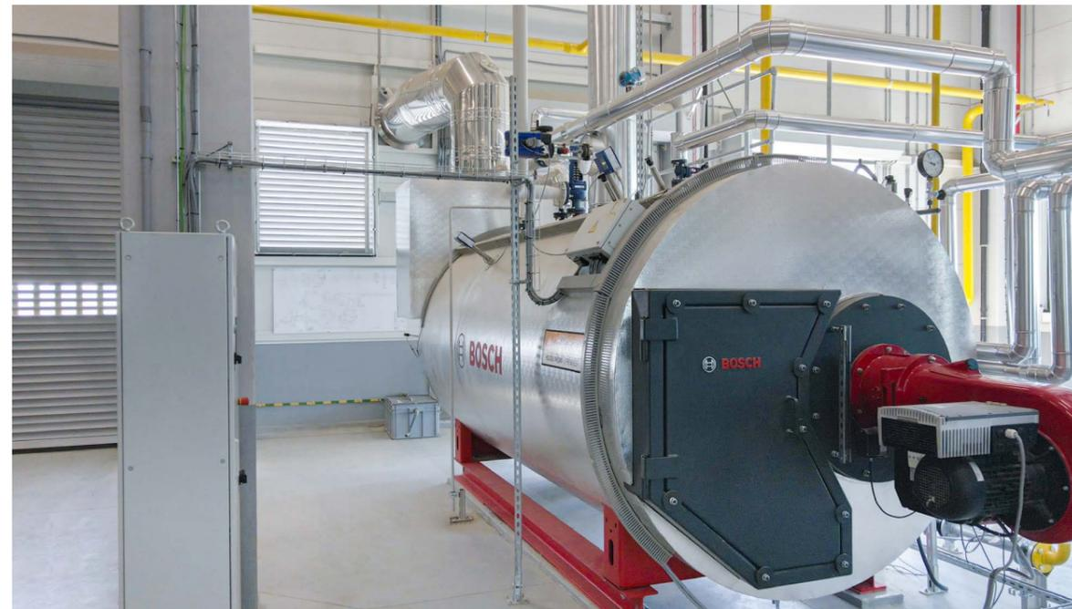
Der Dampfkessel UL-S erzeugt bis zu fünf Tonnen Dampf pro Stunde und bietet ein zuverlässiges Back-up in der Dampfversorgung.
