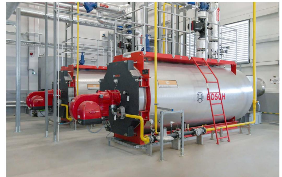
Die Bosch-Heizkessel UT-L unterstützen die Wärmeversorgung der Gebäude und erzeugen bis zu sechs Megawatt Wärme hocheffizient.
