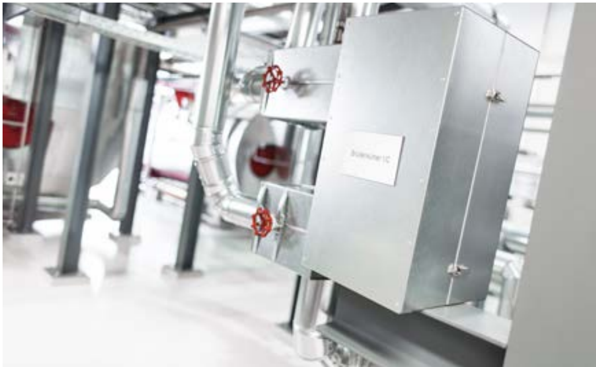
Fig. 159 Vapour cooler
