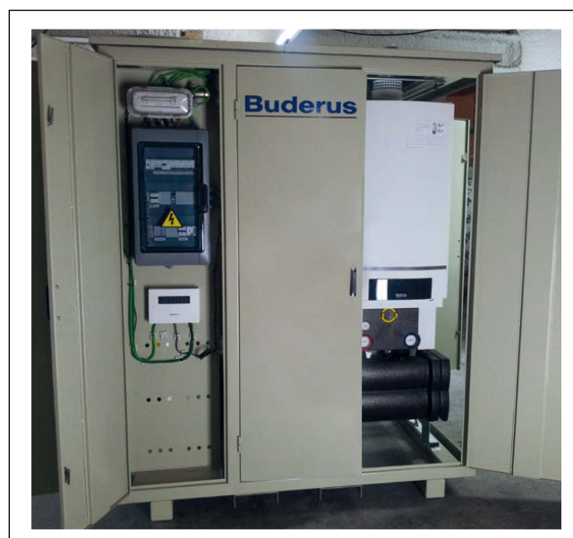
Imagen 4. Detalle de armario eléctrico y elementos de control en un equipo con 4 calderas GB162 V2.
