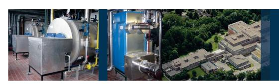
La moderna instalación de la caldera de vapor de Loos con intercambiadores de calor con valor calorífico de acero especial secundarios proporciona energía de forma eficiente en la clínica Itzehoe.
