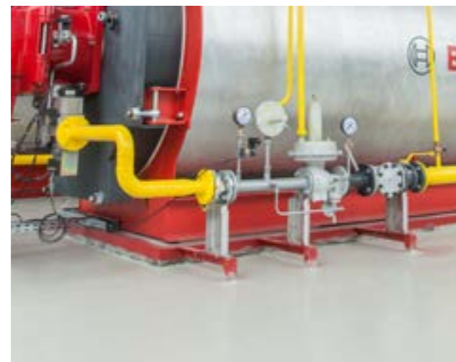
Módulo de regulación de gas GRM
