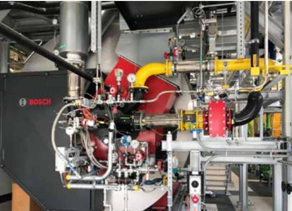
Fig. 4: Ejemplo de aplicación de un concepto de combustible con hidrógeno, gas natural y fuelóleo ligero para un sistema de calderas Bosch en una empresa farmacéutica.
