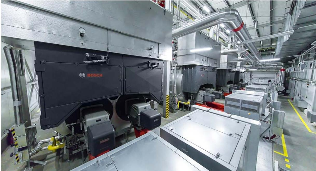
**Fig. 183** Sistema de caldera de vapor ZFR/ZFR-X
