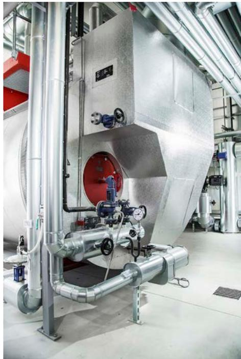
**Fig. 62** Bobina de mantenimiento de calor instalada en la base de la caldera
