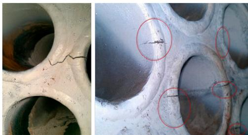
**Fig. 24** Lado de los gases de combustión con grietas en las nervaduras de la placa tubular de la cámara de inversión
