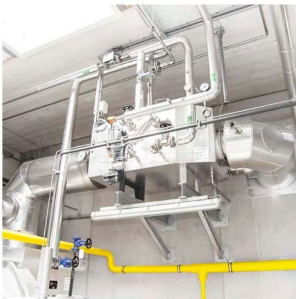
**Fig. 185** Intercambiador de calor de gases de combustión ECO 6 para condensación
