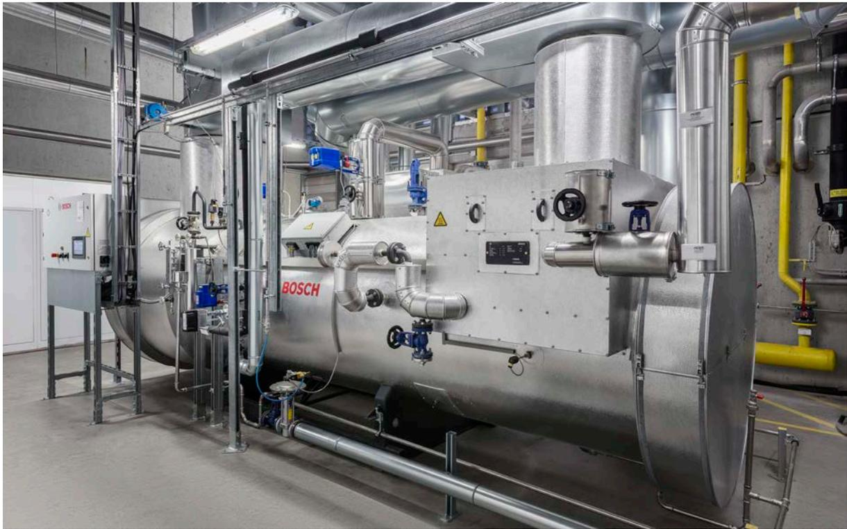
**Fig. 169** Caldera de recuperación de calor HRSB de Bosch
