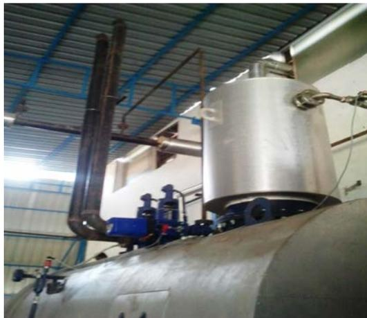
**Fig. 20** *Faltan los soportes de los tubos de descarga de las válvulas de seguridad*
