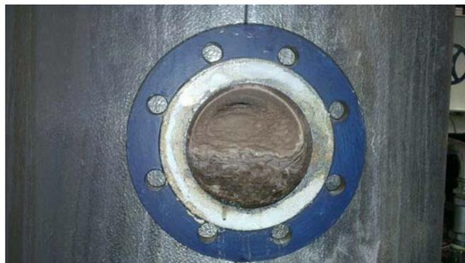
**Fig. 32** Desbordamiento en BEM eliminado; calcificación completa en BEM.
