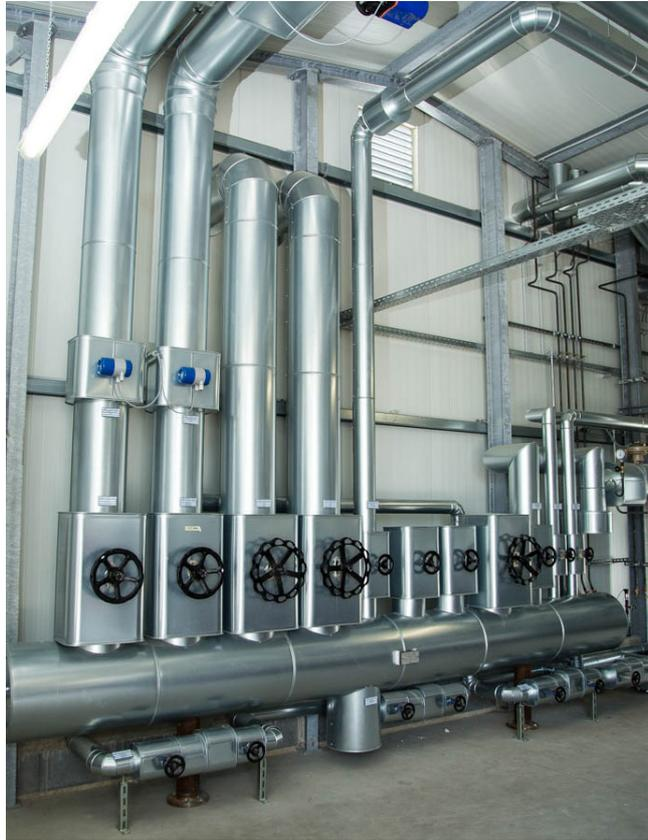
**Fig. 182** Distribuidor de vapor SD
