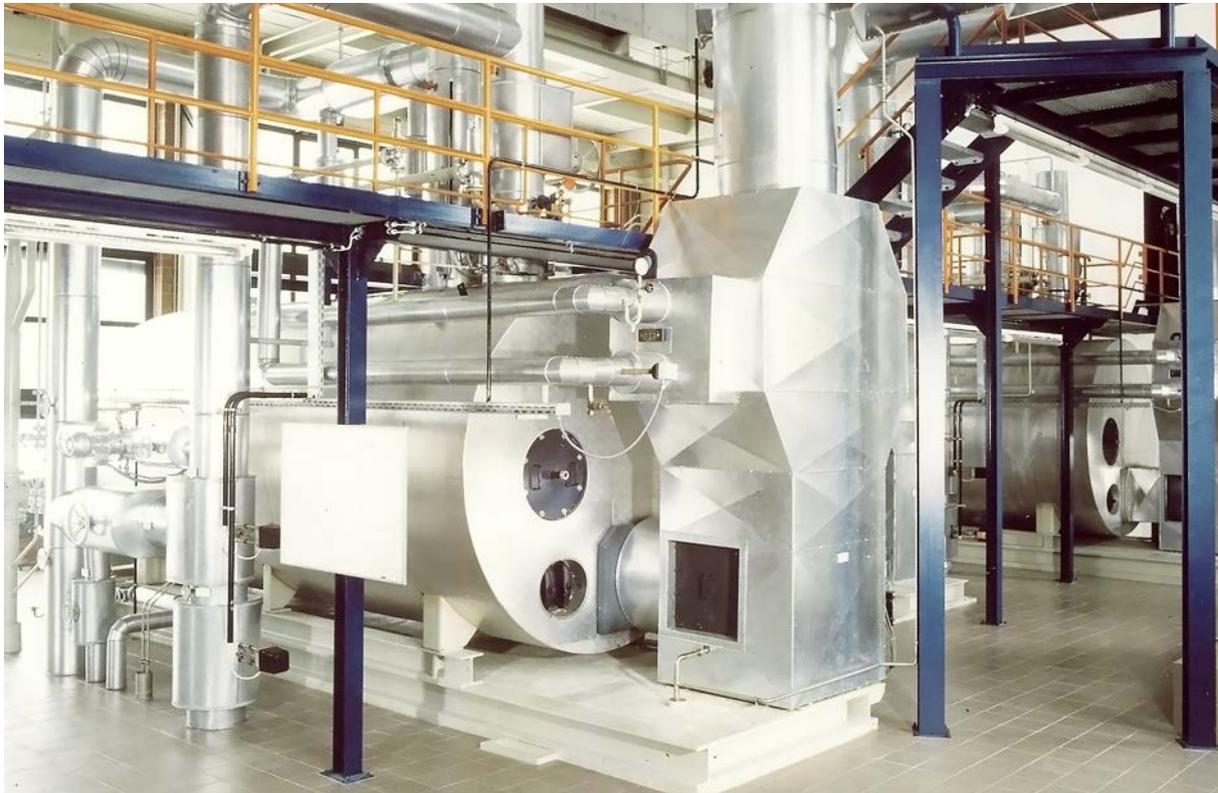
**Fig. 67** Economizador autónomo en combinación con un sistema de combustión dual (gas/aceite pesado)
