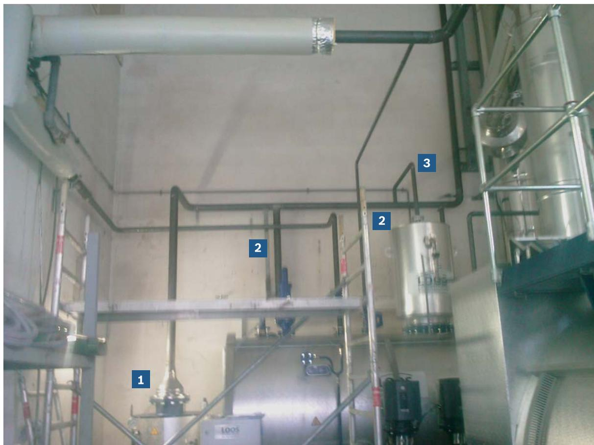
**Fig. 18** Estrechamiento (1) de la tubería de vapor de expansión en el depósito de descarga inferior. Unión (2) de la tubería de vapor de expansión, la tubería de descarga de la válvula de seguridad y la tubería de vapor de escape. Tubería de vapor de escape no fabricada en acero inoxidable (3).
