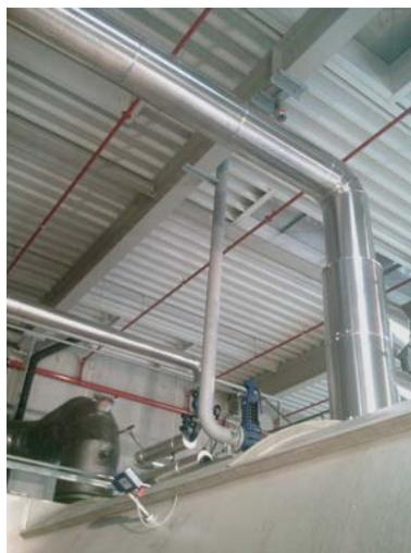
**Fig. 21** *No es posible la dilatación térmica de los tubos de descarga de la válvula de seguridad*
