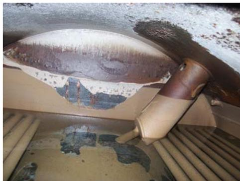
**Fig. 23** Depósitos del lado del agua en el panel tubular y la placa tubular de la caldera
