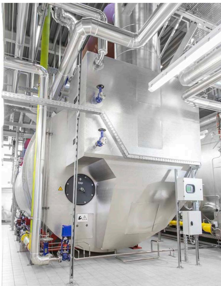
**Fig. 165** Aislamiento desmontable en las aberturas de inspección (UL-S con economizador integrado)
