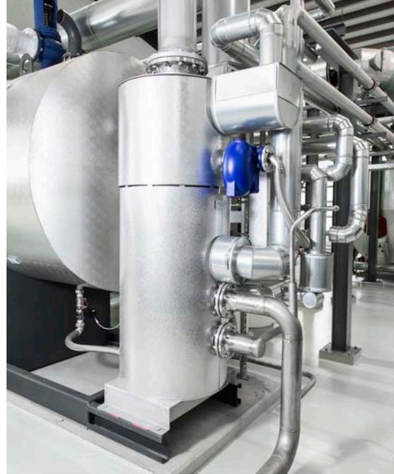
**Fig. 174** Módulo de expansión, recuperación de calor y purga EHB
