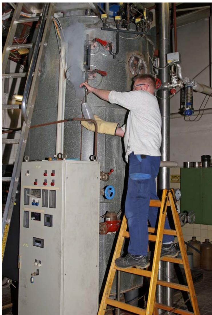
**Fig. 34** Muestreo de agua sin refrigerador adecuado y con recipiente inadecuado
