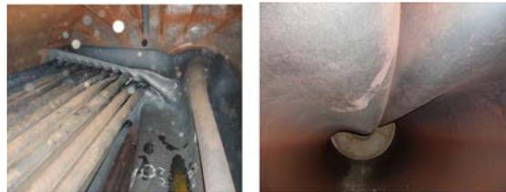
**Fig. 33** Deformación por sobrecalentamiento debido a la escasez de agua
