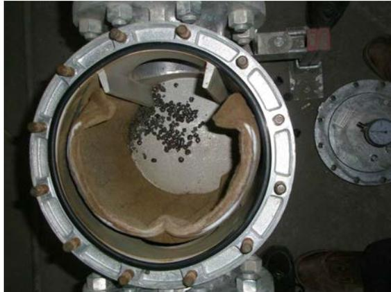
**Fig. 31** Cordones de soldadura y óxido en el filtro de gas
