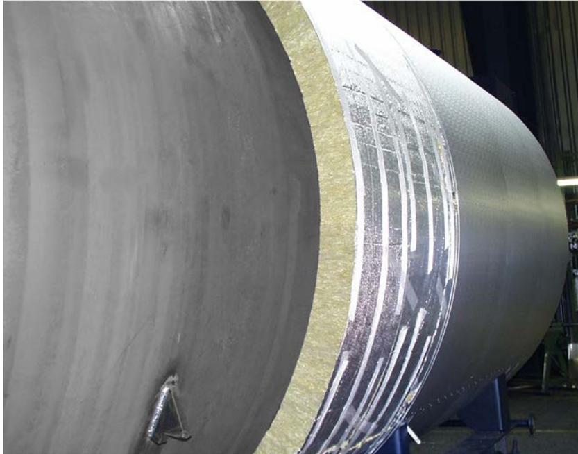
**Fig. 164** Evitar puentes térmicos aislando calderas cilíndricas y envases sin separadores
