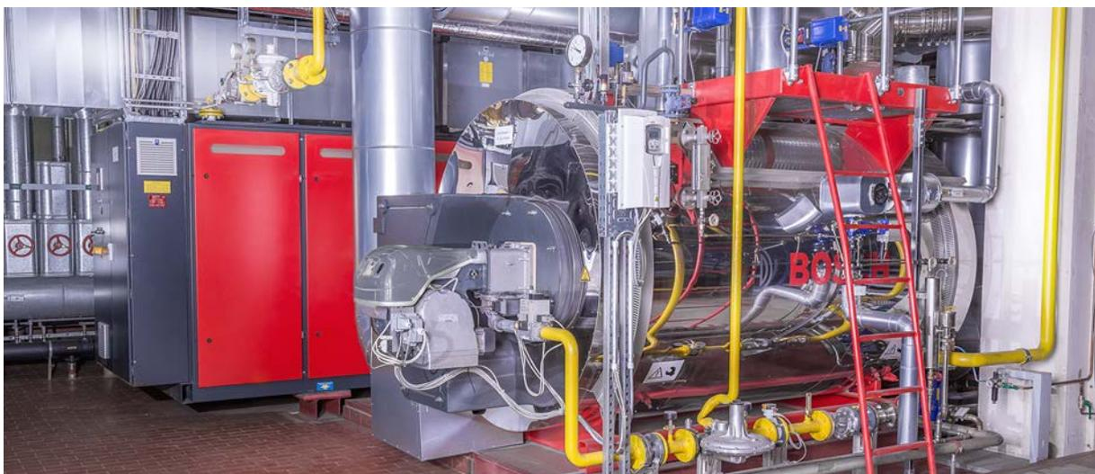
**Fig. 61** Unidad combinada de calor y electricidad con caldera de calor residual de 4 pasos
