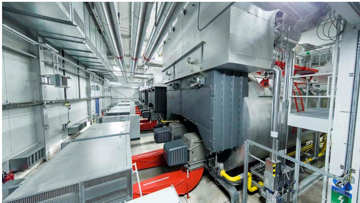
**Fig. 189** Caldera pirotubular con módulo de sobrecalentamiento
