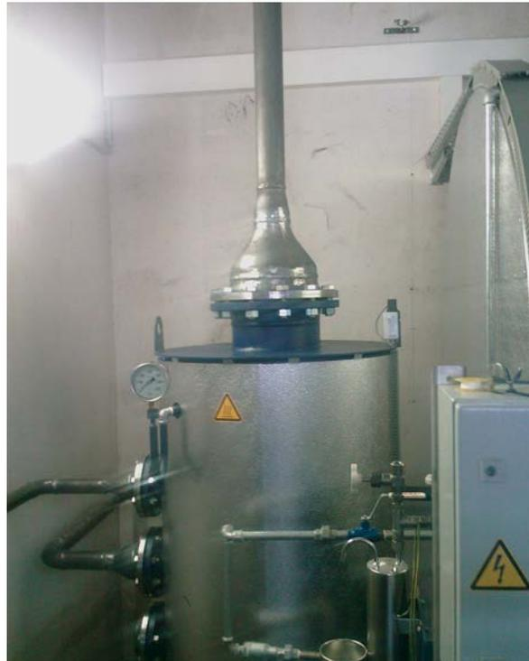
**Fig. 17** Si se reduce el diámetro interno de las tuberías de vapor de expansión, puede producirse un aumento de la presión y la rotura del recipiente
