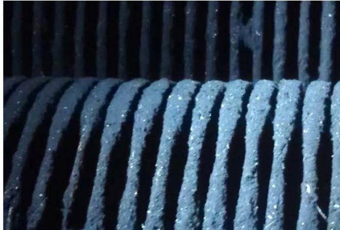
**Fig. 29** Depósitos en las nervaduras del economizador
