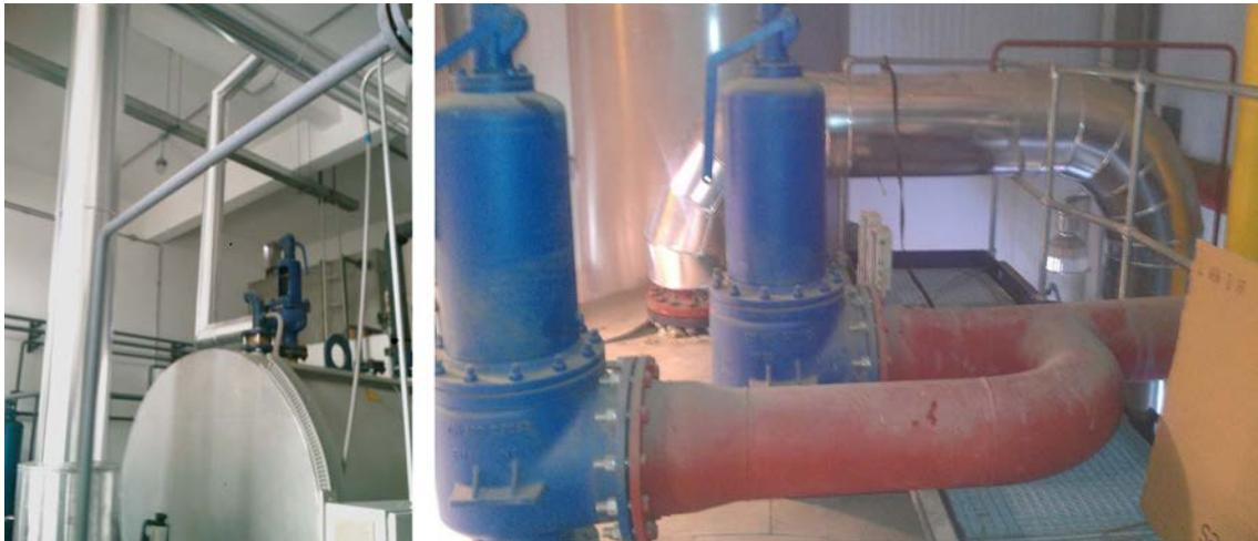
**Fig. 16** Fusión no permitida de válvula de seguridad y tubería de vapor de expansión.
