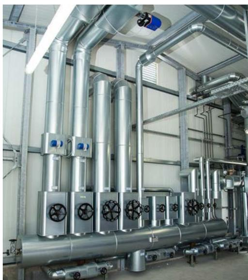
**Fig. 198** Distribuidor de vapor SD en el sistema existente
