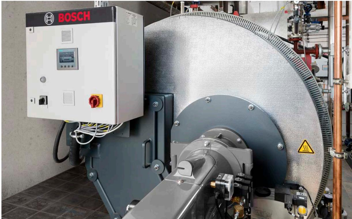
**Fig. 85** Armario de control compacto de CSC para calderas de vapor de menor potencia
