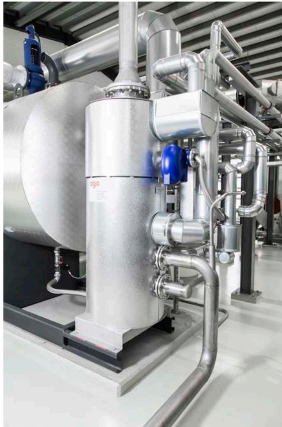
**Fig. 157** Módulo de expansión y recuperación de calor EHB
