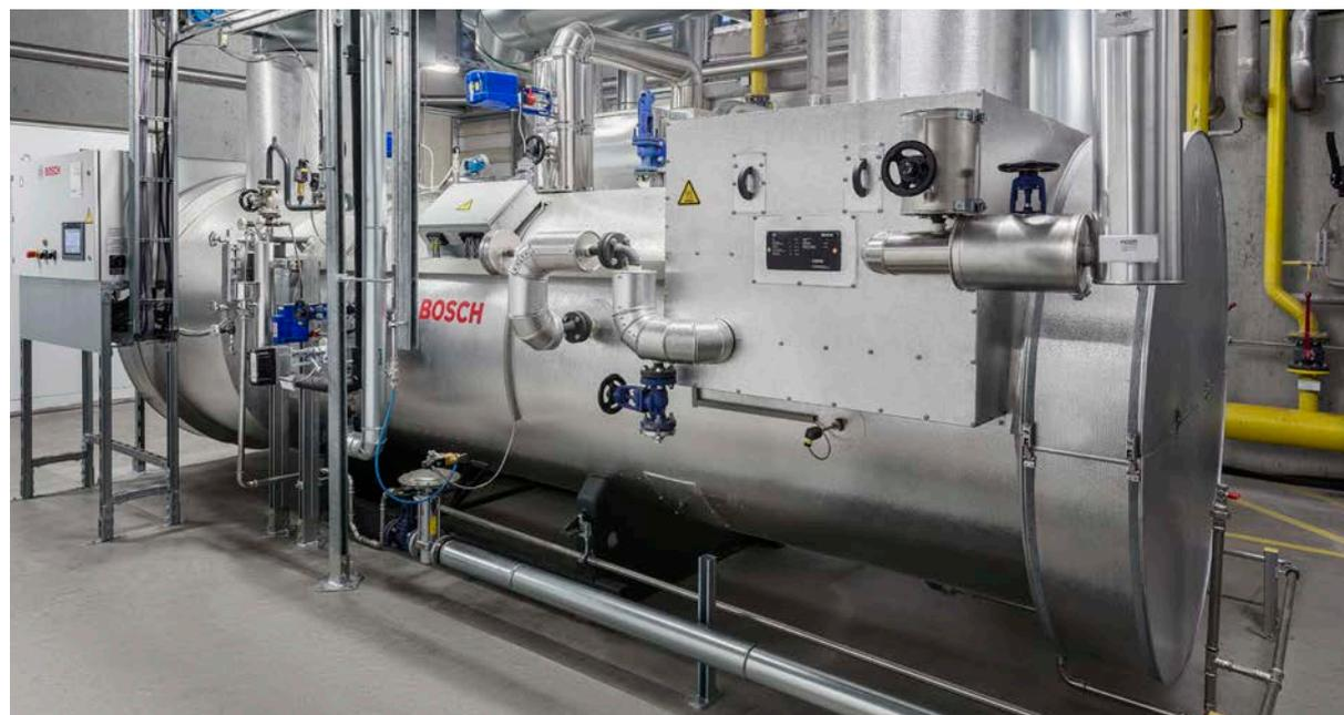
**Fig. 190** Caldera de vapor con recuperación de calor UNIVERSAL Sistema HRSB
