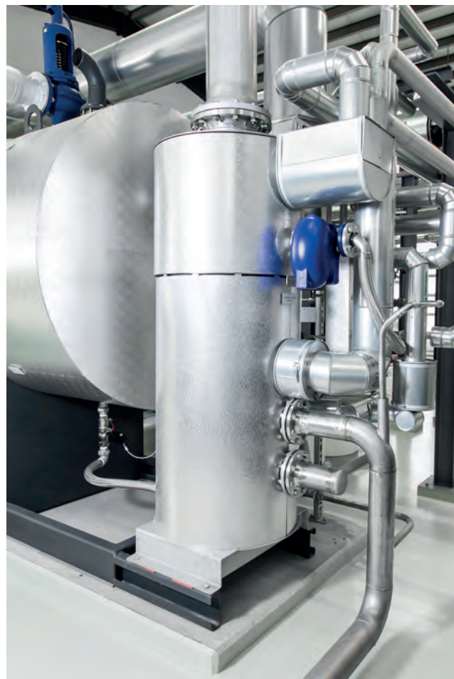
Módulo de expansão, de recuperação de calor e de água de descarga EHB
