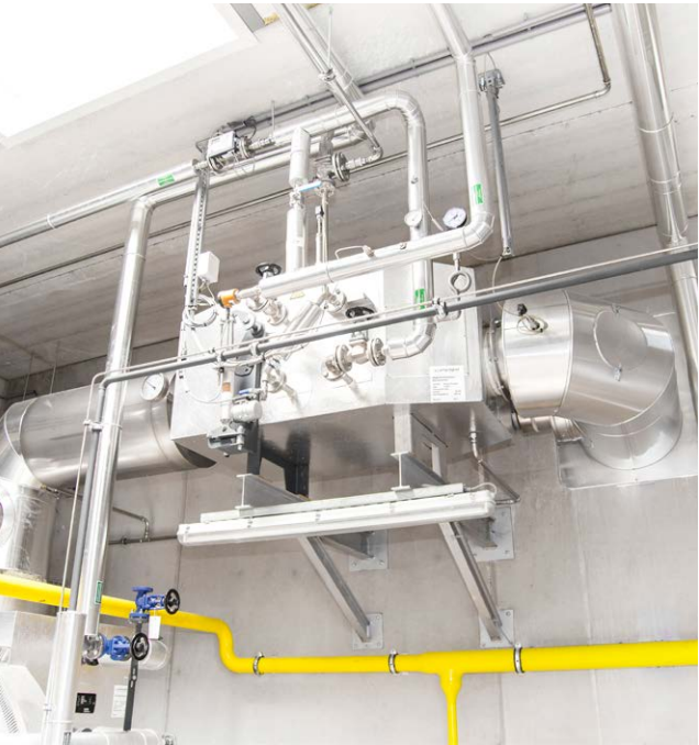
Spalinový výměník tepla ECO 6 pro využití kondenzace
