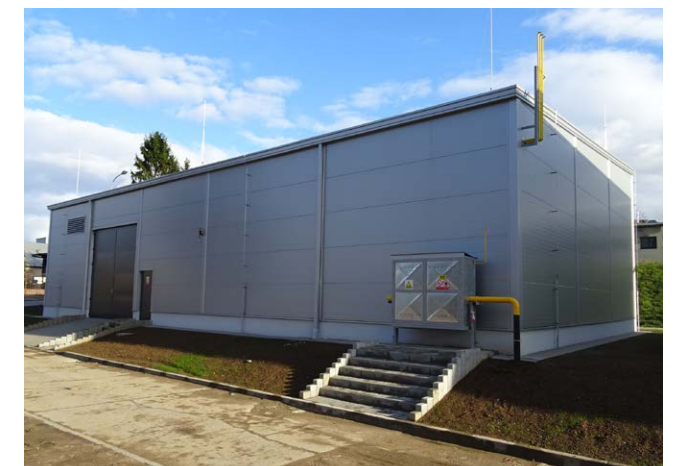
Nová kotelná A2 v areálu Iveco ve Vysokém Mýtě
