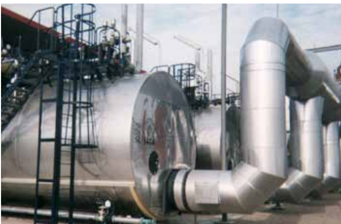
Obrázok 11: Poveternostne odolná izolácia pre vonkajšie inštalácie
