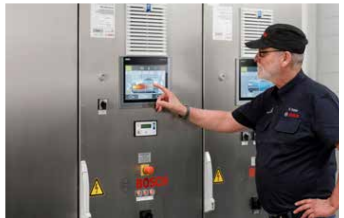
Obrázok 12: Skriňový rozvádzač Bosch, vyhotovenie v nerezovej oceli
