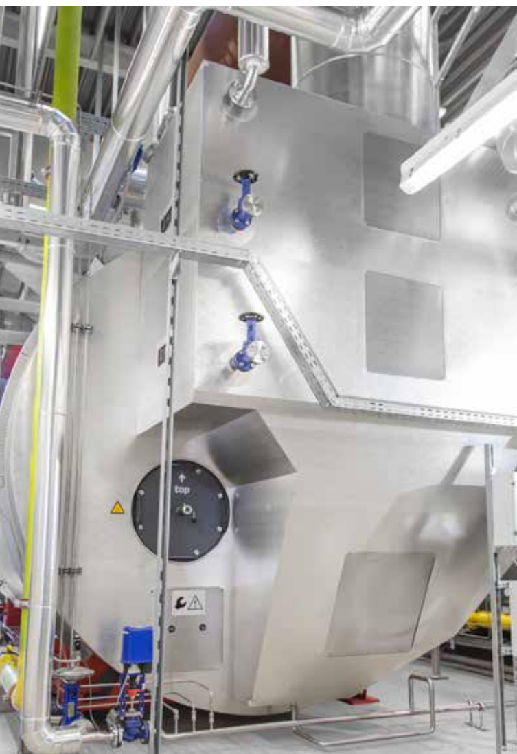
Obrázok 1: Kotel UL-S, izolácia so štruktúrovaným hliníkovým plášťom a s izolovanými revíznymi otvormi
