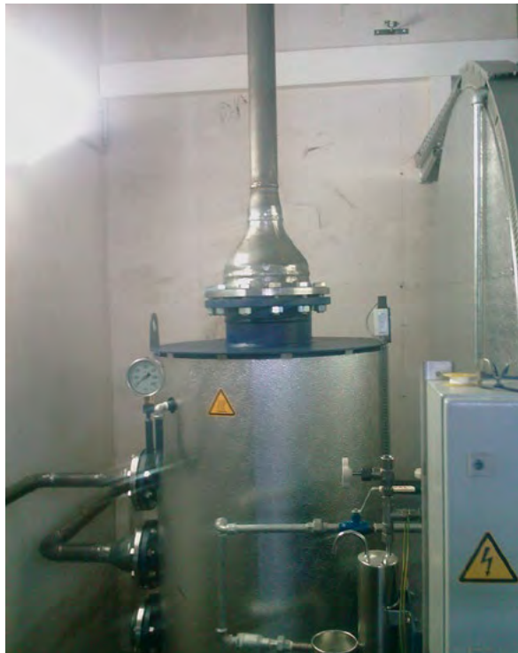
Obr. 17 Redukce potrubí expandované páry může vést k nárůstu tlaku v zásobníku a tím k jeho roztržení
