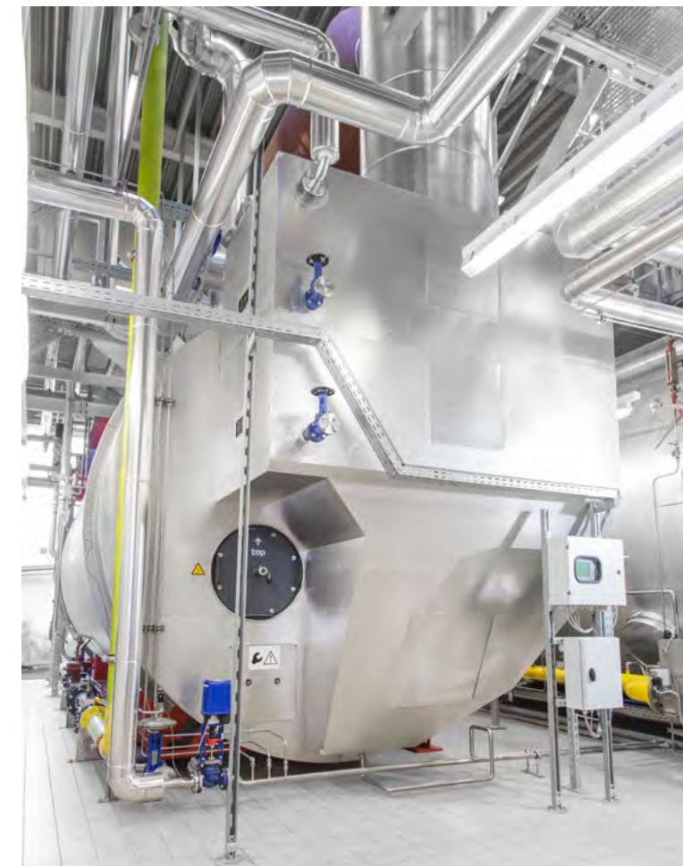
Obr. 166 Odnímatelné izolace na revizních otvorech (UL-S s integrovaným ekonomizérem)
