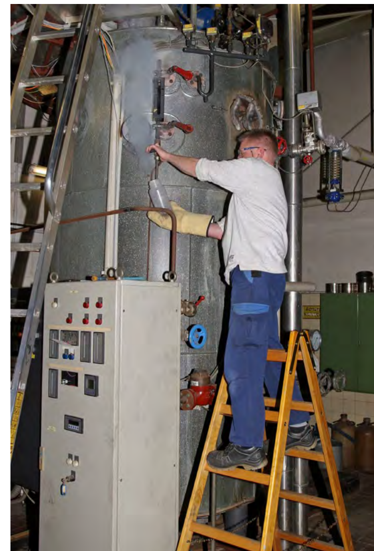
Obr. 34 Odběr vzorků vody bez vhodného chladiče a s nevhodnou nádobou
