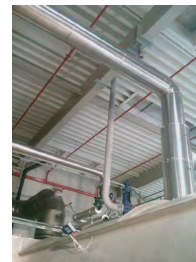
Obr. 21 Tepelná roztažnost potrubí odfuku bezpečnostních ventilů není možná
