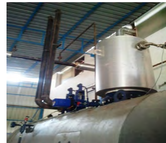
Obr. 20 Chybějící fixační závěsy/držáky potrubí odfuku pojistných ventilů
