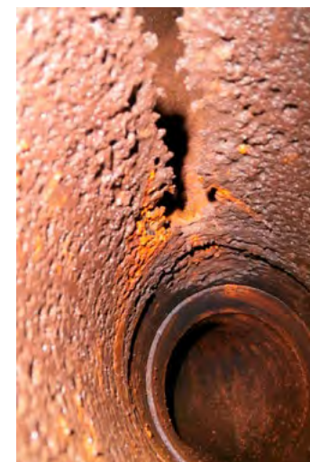
Obr. 15 Vypouštění odpadních vod nad 100 °C na odpadní jímce pod hladinou vody (na hrdle pro < 100 °C)
