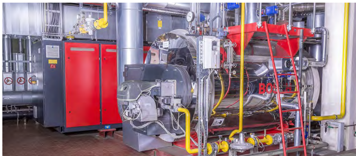
Obr. 61 Kogenerace se 4 tahovým spalínovým kotlem
