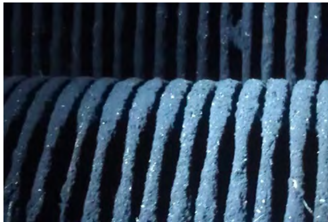
Obr. 29 Usazeniny na žebrech ekonomizéru
