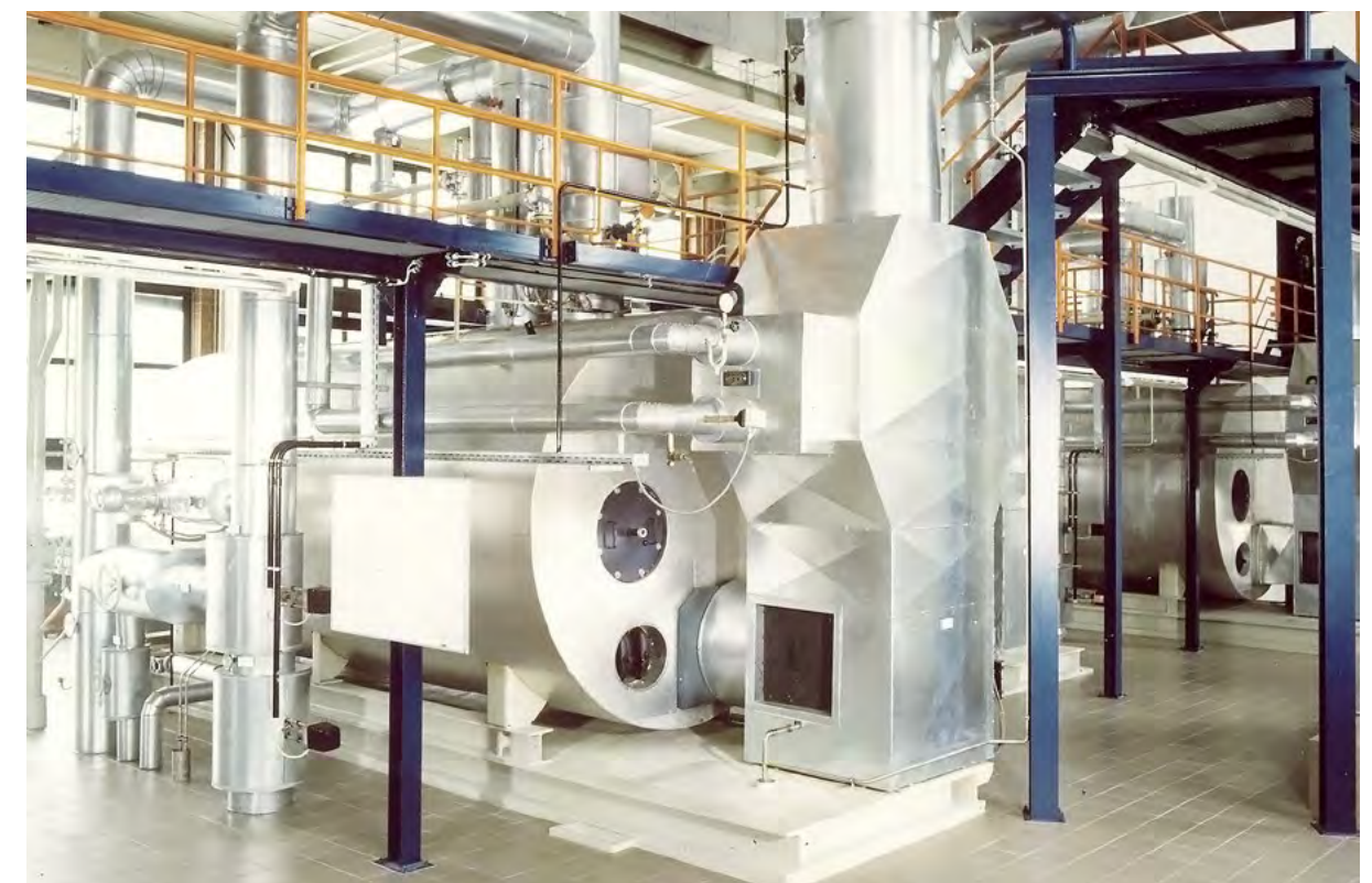
Obr. 67 Ekonomizér Stand-Alone ve spojení s duálním spalovacím zařízením (plyn/ těžký topný olej)
