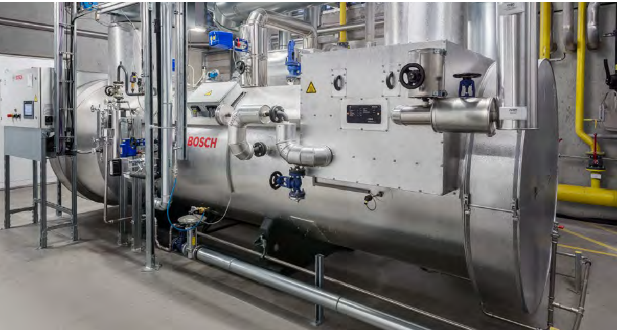
Obr. 191 Zařízení spalinového kotle UNIVERSAL HRSB
