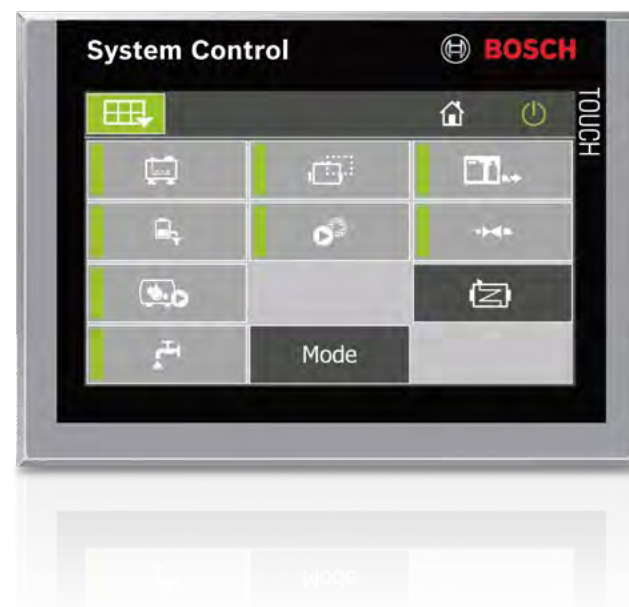
Obr. 224 Homescreen řídicího systému kotelny System Control SCO
