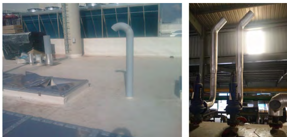
Obr. 19 Odfuk pojistného ventilu
