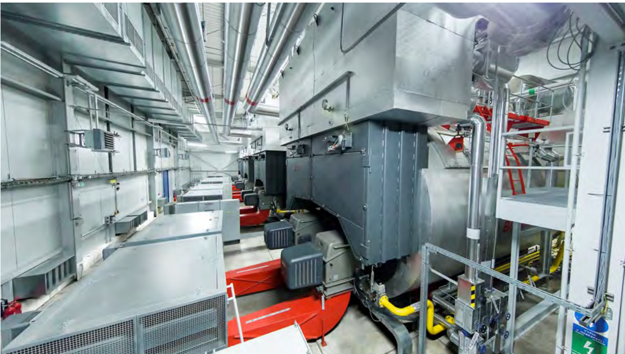
Obr. 190 Dvouplamencový kotel s modulem přehříváku
