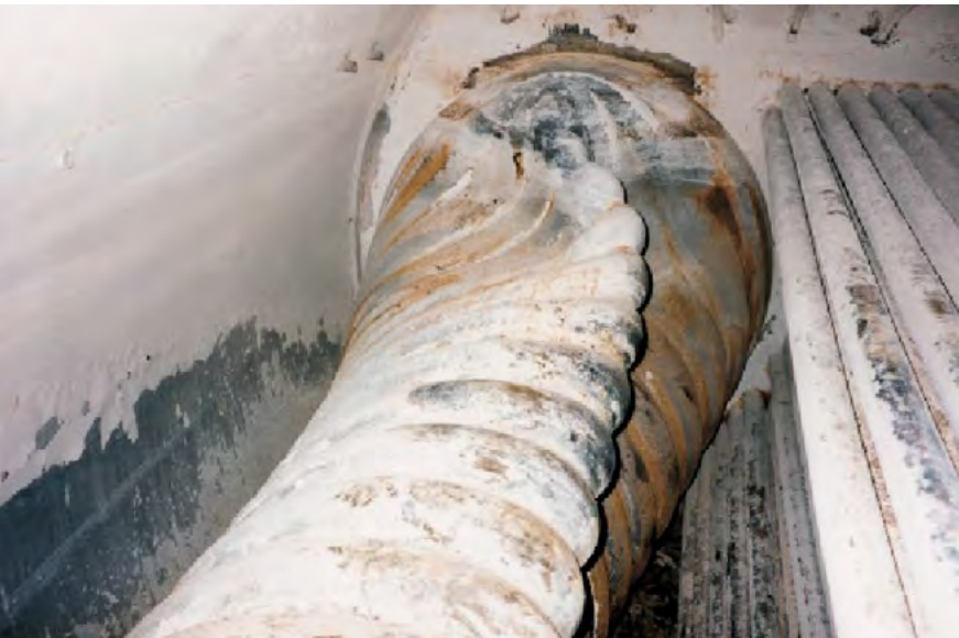
Obr. 90 Tvorba povlaku v kotli se škodami na plamenci
