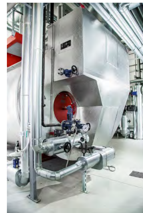
Obr. 62 Topný had namontovaný ve dně kotle pro udržování v teplém stavu
